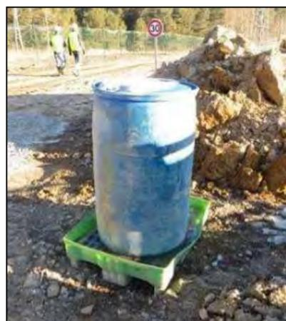
Figure 65 : Stockage d'hydrocarbures dans un bidon étanche sur bac de rétention (Source : Abies, suivi de chantier)
