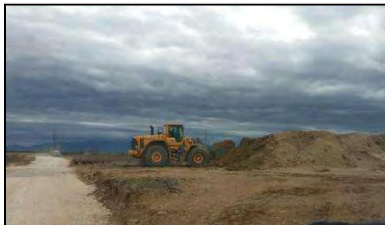
Figure 69 : Reprise de la terre stockée pour le remblayage des fondations (Source : Abies, suivi de chantier éolien)
