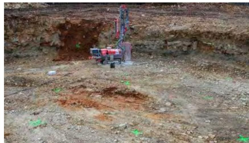
Figure 64 : Foreuse géotechnique sur un chantier éolien (Source : Abies)
